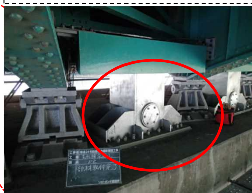
支承補強構造(橋軸直角方向)
