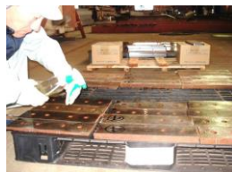
噴霧による薬品塗布 (ヒットロックB)
